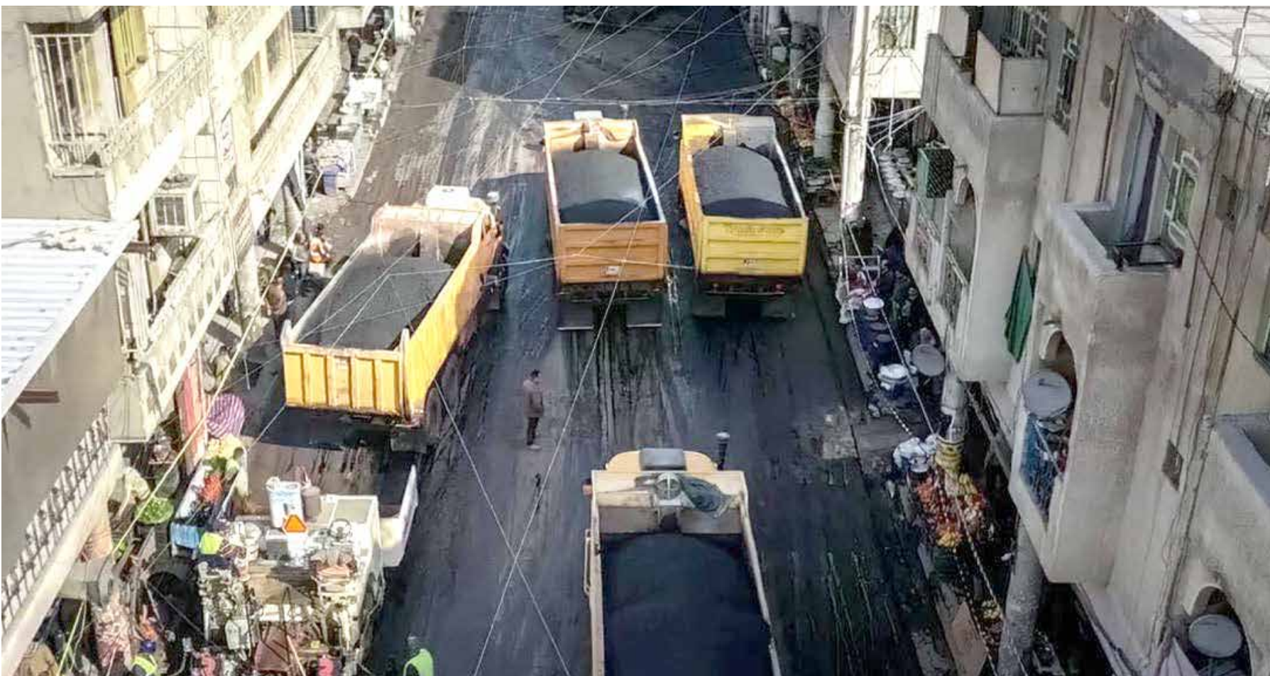
عملية الاكساء في شوارع الصدرية
