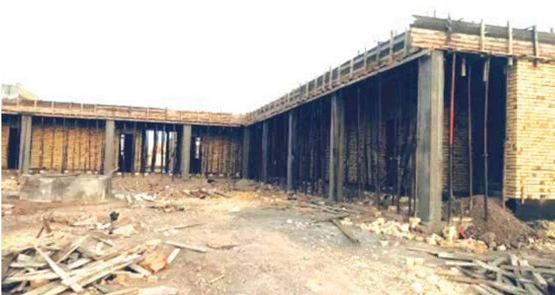
من داخل المدرسة وهي في طور البناء
