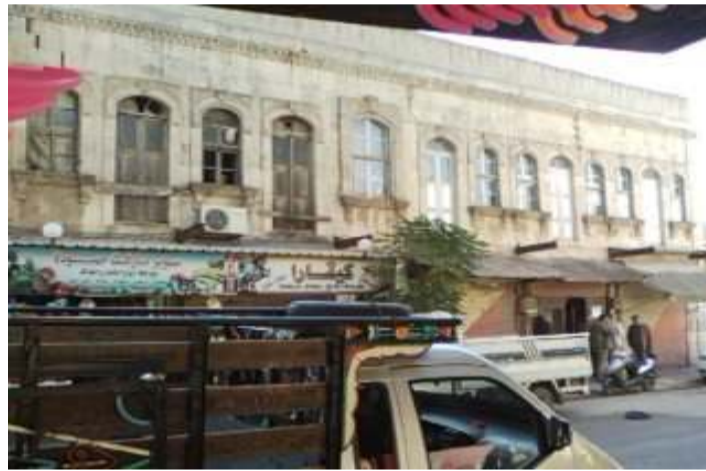
الواجهة الشمالية لبناء درويش شمو آغا
